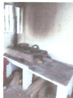
MANTENIMIENTO DE ESTUFA, CAMBIO DE PLANCHA, CHIMENEA
