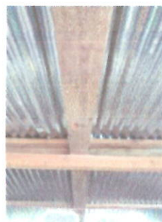
ESTRUCTURA DE MADERA, SUSTITUCION DE ESTRUCTURA DE MADERA EN AULA DE PARVULOS
