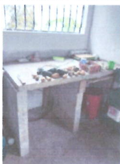
REPARACION DE AREA DE COCINA, SUSTITUCION DE AZULEJO EN MESON
