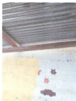
CUBIERTA DE LAMINA, SUSTITUCION DE CUBIERTA DE LAMINA EN MAL ESTADO, PINTURA EN MUROS, APLICACIÓN DE PINTURA EN MUROS EN MAL ESTADO
